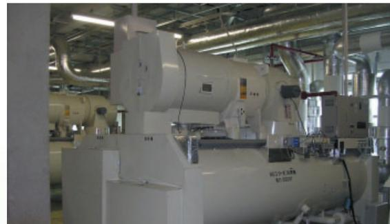
生産子会社・第一三共プロファーマの静岡工場では、既存設備の老朽化による更新に際し、エネルギー効率とCO<sub>2</sub>発生低減に優れたターボ冷凍機(写真)を導入しました。これにより同地区では、電気使用量が若干増加したものの重油使用量が大幅に減少し、CO<sub>2</sub>排出量が約2,000トン削減されました。
