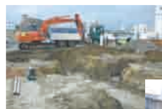
第一三共プロファーマ高槻工場 新事務棟建設現場
