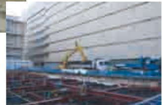
品川研究開発センター 汚染土積み込み風景
