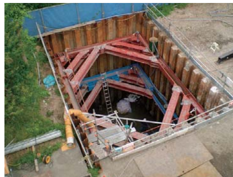
第一三共ケミカルファーマ小田原工場 工事状況
