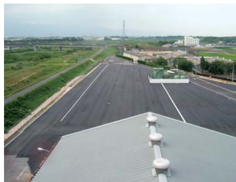
工事終了後の旧三共野洲川工場跡地
