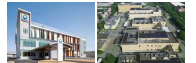
小名浜工場 管理棟
