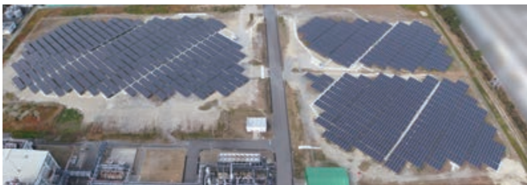
小名浜 太陽光発電設備
