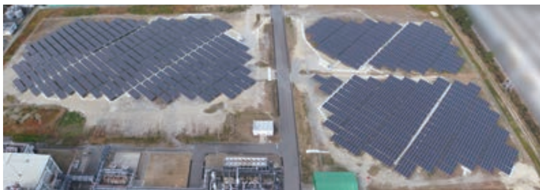
小名浜 太陽光発電設備
